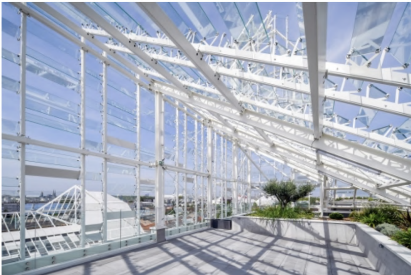
Au dernier étage, un espace extérieur offre une vue panoramique sur Bordeaux. Crédits : A. Gilbert
